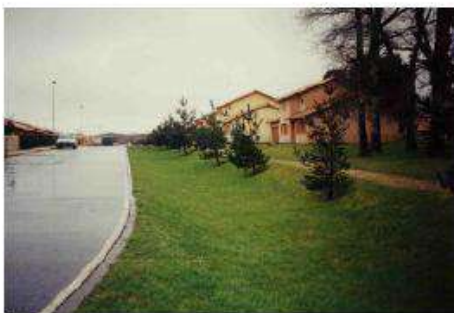
Noue le long d'une voie desservant un habitat aéré Source CETE du Sud-Ouest
