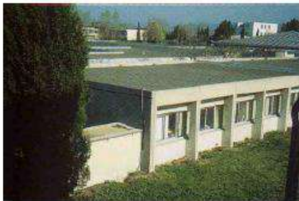
Toiture – terrasse Source CERTU
