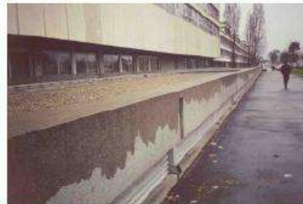
Aménagement en décroché de toiture-terrasse sur site hospitalier Source CETE du Sud-Ouest
