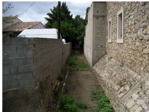
ruisseau-fossé rue Noble
