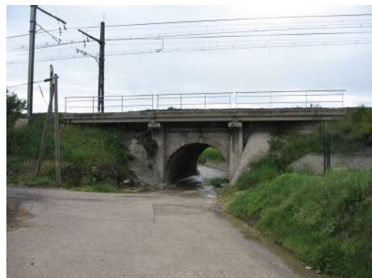
passage sous la voie ferrée
